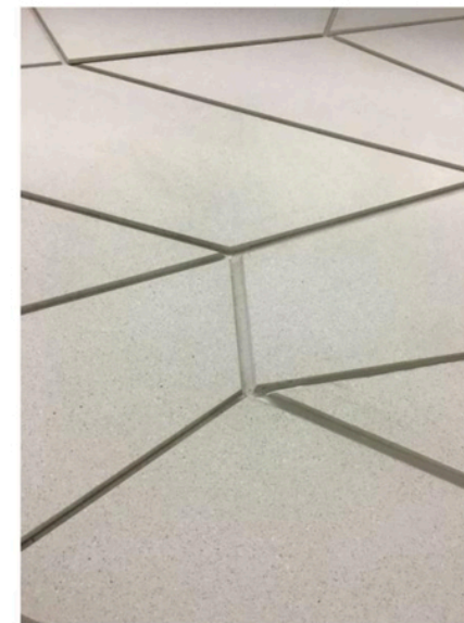
Bild 12 Betonsteinplatten, Detail des Kontinuums, Wehrhahn-Linie, Foto: UTE LATZKE Artificial stone slabs, detail from the Kontinuum, Wehrhahn Line
