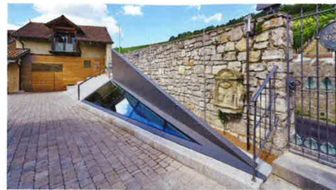
Ein großes dreieckiges Oberlicht stellt eine architektonische Verbindung zum Außenraum her.
